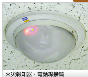
火災報知器・電話線接続
