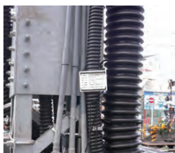
鉄道関連工事 (地上配線工事)
