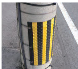
電力(電柱)・ 電灯工事
